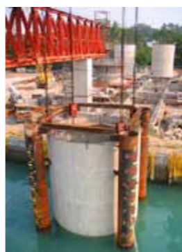
Caisson Loadout
